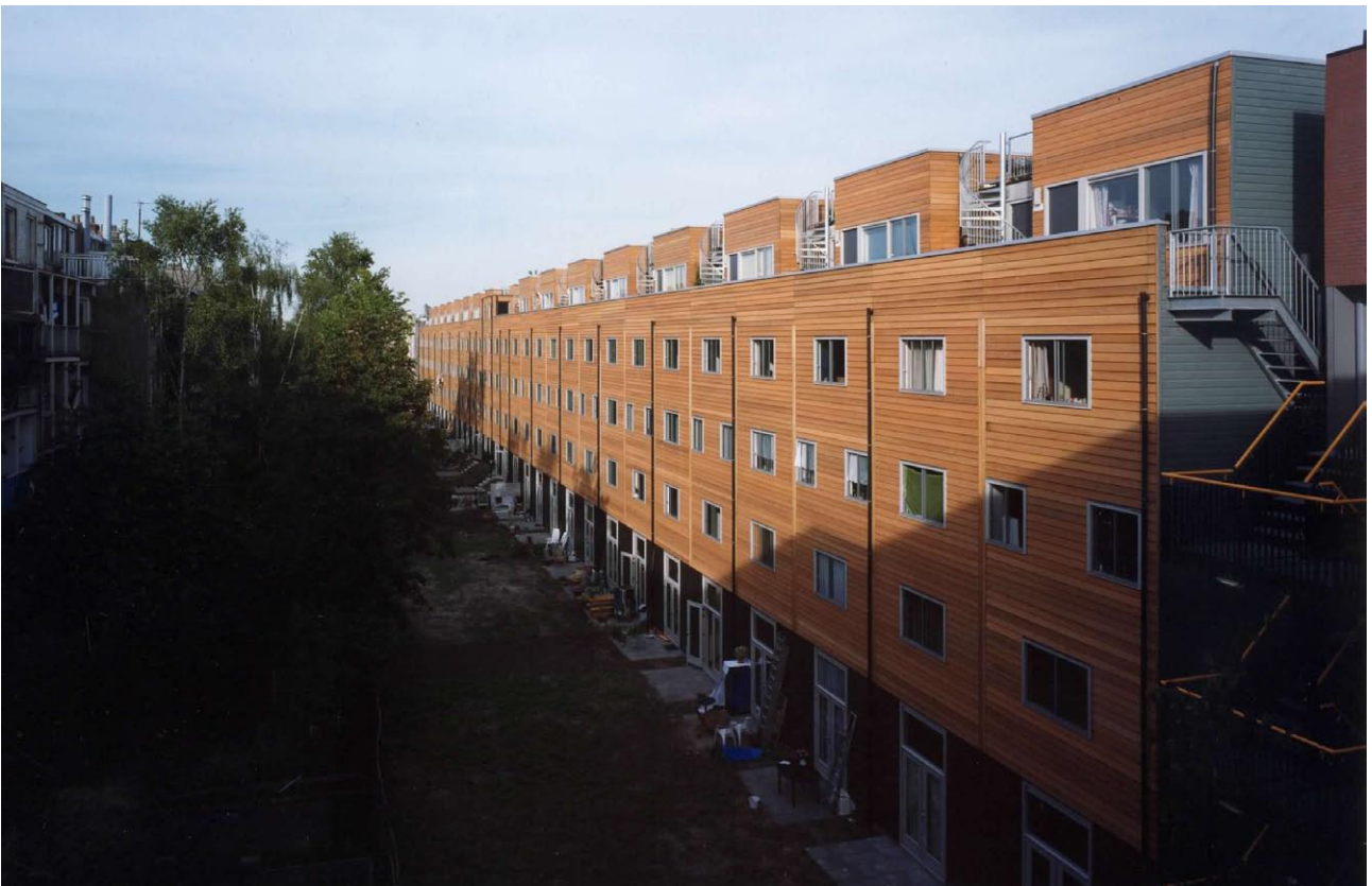
De de houten achtergevel heft een setback waardoor deze minder hoog oogt vanuit de averkant
