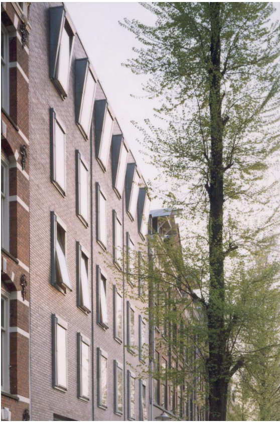
De ramen op de 4e verdieping zijn naar voren gekanteld waardoor de gevel aan de bovenkant wordt beëindigd
