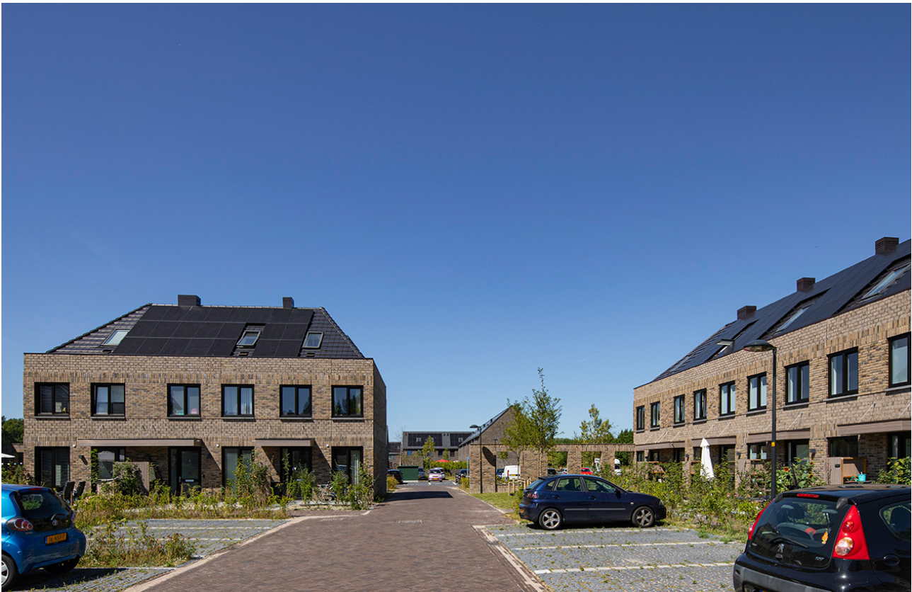
Parkeerplaatsen Poortgebouw Noord
