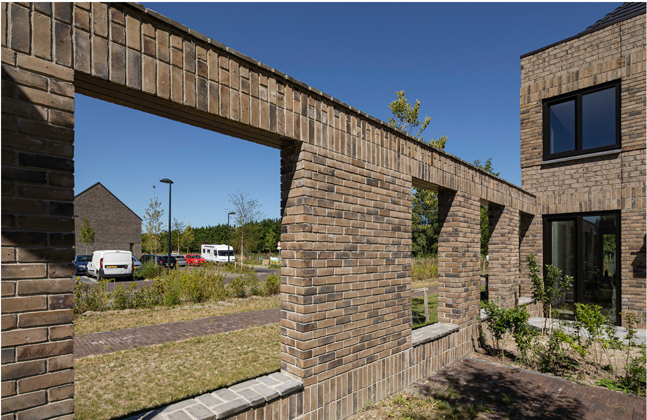
Detail Poortgebouw muur
