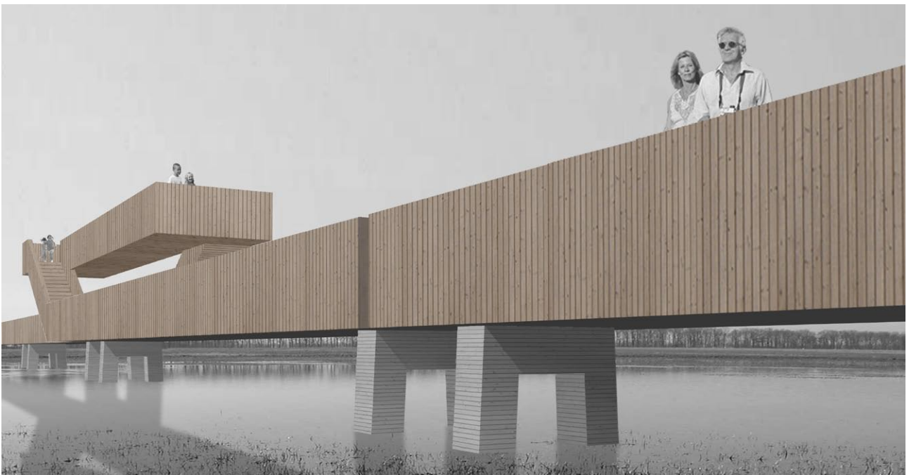
De 'knoop' met het uitzichtplatform. De brug is bekleed met houten latten, de betonnen pijlers en aanlandingsstukken zijn van beton met een latjesbekisting
