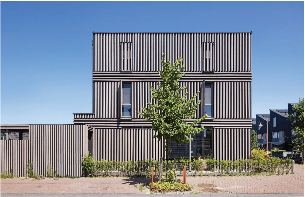
Detail van de gevel met houten latten.
