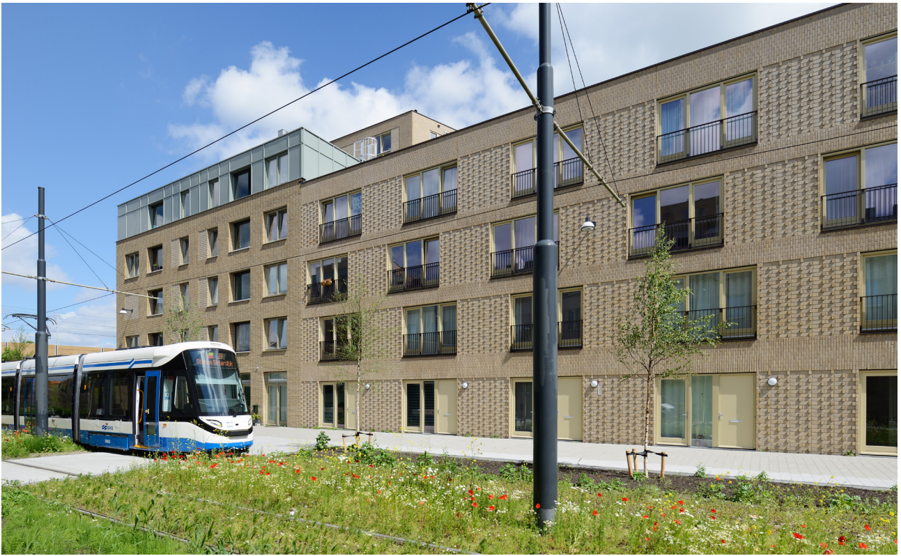
Tram vanuit Amsterdam, die om blok T heen rijdt.
